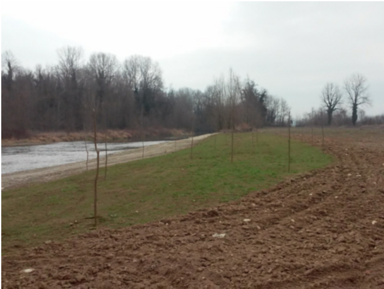
Post Operam - Torrente Maira - Comune di Racconigi Ripristino sponda sinistra mediante realizzazione di repellenti in massi di cava non cementati, imbottimento spondale e successiva semina e piantumazione di esemplari arborei
